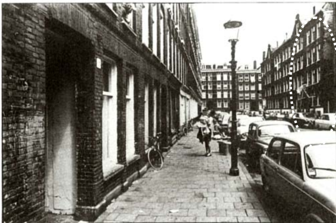
De Burgerstraat gezien vanuit het westen, ca. 1971, met uitzicht op de Tollensstraat; omcirkeld de voorgevel van het clubhuis van het St-Franciscus Liefdewerk (S.F.L.)
