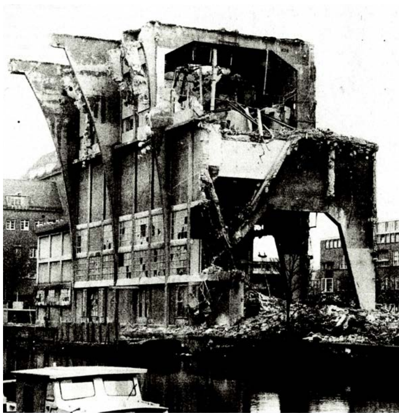
Het ketelhuis van Het Wilhelmina Gasthuis, tijdens de sloop (1982-1984)
